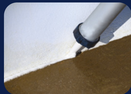
KROK 3 Naprawa pęknięć i szczelin
