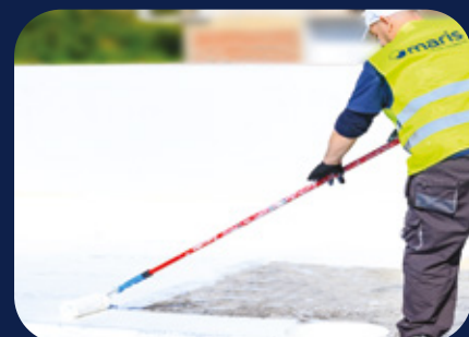
KROK 6 Zazbrojenie pierwszej warstwy membrany hydroizolacyjnej
