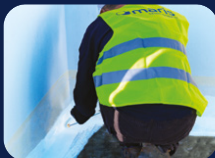
KROK 5 Połączenia posadzka-ściana
