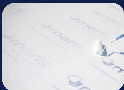
KROK 7 Druga warstwa membrany hydroizolacyjnej
